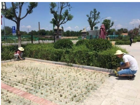
植草砖铺装面积核查
